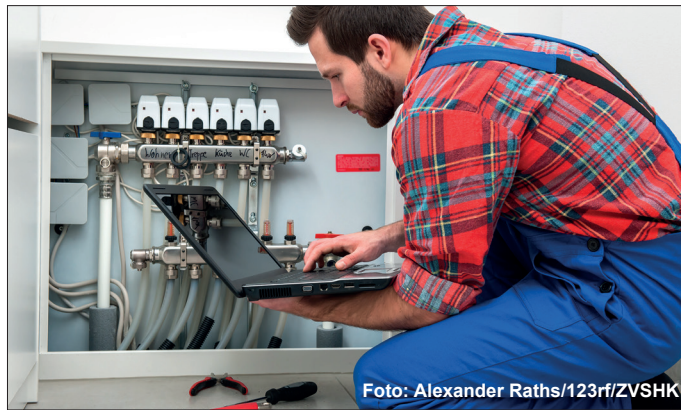
txn. Eine Fußbodenheizung sorgt für Behaglichkeit und steigert den Wohnkomfort. Voraussetzung ist der hydraulische Abgleich durch den Heizungsfachmann.
