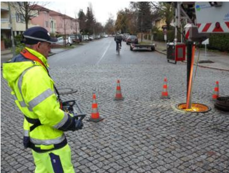
Reinigungsarbeiten mit sicherem Abstand (Quelle: BWB)
