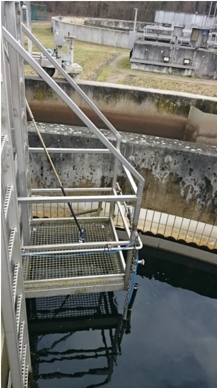
Gesicherter Standplatz an Beckenanlage (Quelle: DAR)
